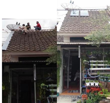
Gambar 3. Pemasangan panel surya
