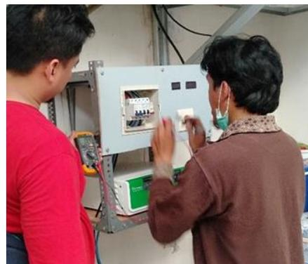
Gambar 4. Pemasangan *controller hybrid*
