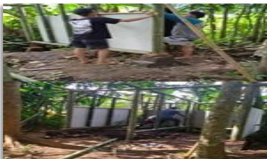
**Gambar 4.** Pemasangan sekat kamar ganti menggunakan calsisboard
