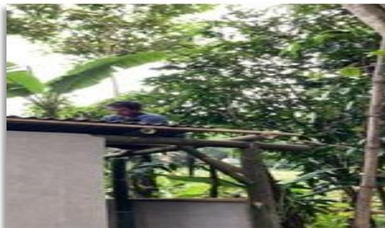
**Gambar 5.** Pemasangan atap berbahan asbes
