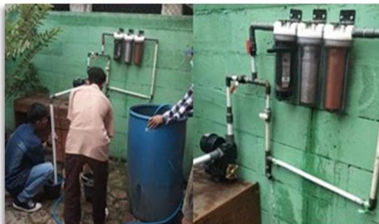
**Gambar 3.** Pemasangan Instalasi Alat Pengolahan Air Menggunakan Membran Keramik
